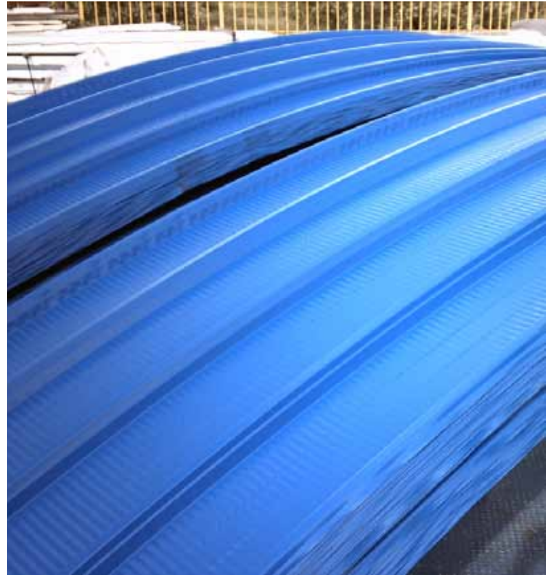
Un particolare della lavorazione dell'acciaio
